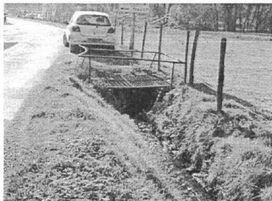
Busage du Drand avant son passage du canal Mouturier
