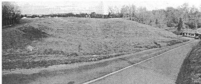
Emplacement réservé pour le bassin, route de Combécot
